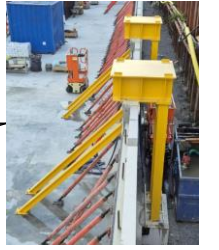
Kranfundament till Olivin
