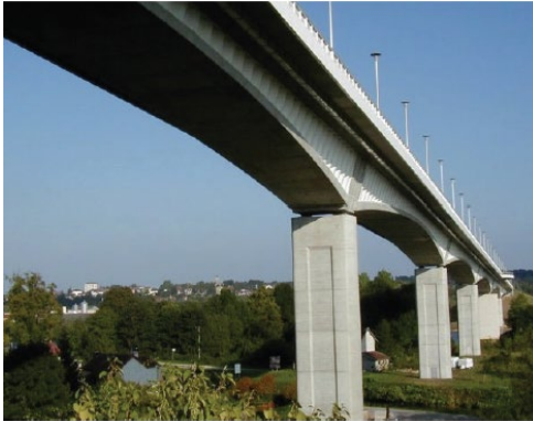
Box-girder bridge, Pont en poutre-caisson, France
