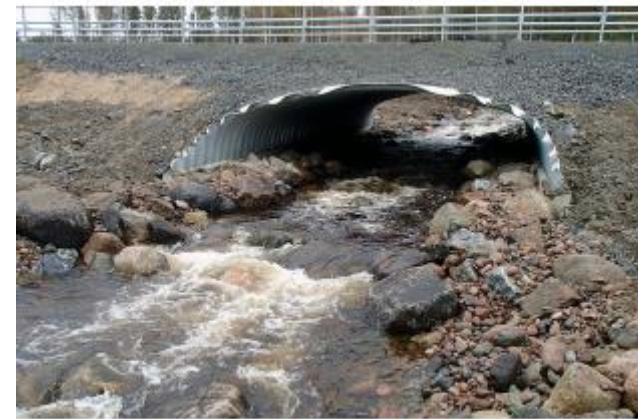
Bro över Njallebäcken med strandpassager. Foto: Trafikverket.
